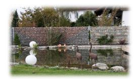
Führle Cum lapis ist ein vielseitig kombinierbares und verfüllbares Modulsystem für die individuelle Gartengestaltung. Es ist in 10 verschiedenen Höhen und 4 Wandstärken lieferbar. Das System besteht aus feuerverzinkten Pfosten und Korbmatten sowie Mattenverbindern und Hakenschrauben aus Edelstahl.
