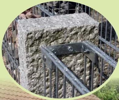
Die Gitter-Stein-Wand wird mit Montagehaltern am Stelenmodul befestigt.
