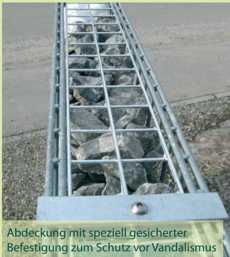
Abdeckung mit speziell gesicherter Befestigung zum Schutz vor Vandalismus
