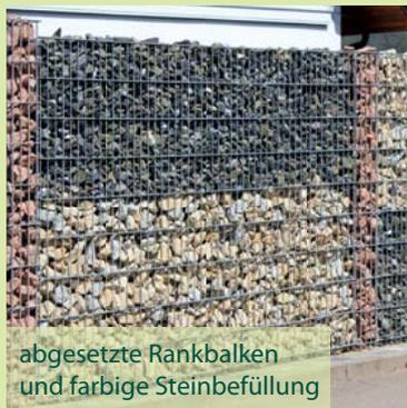
abgesetzte Rankbalken und farbige Steinbefüllung
