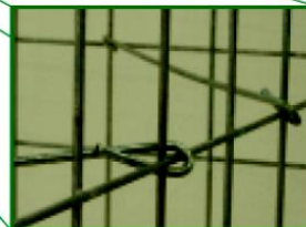
Wenn notwendig, Spirale mit Zange schließen.
